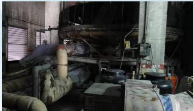
冷卻水塔散熱不良並搭配定頻泵浦
